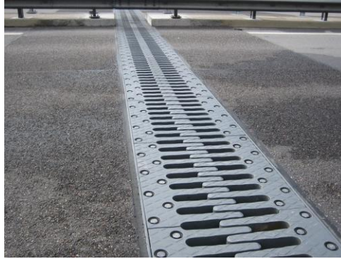
Figur 3.7: Illustrasjon av fingerfuge [29]
