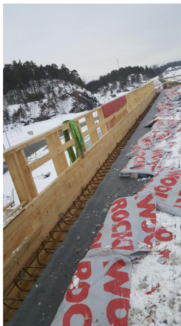
Figur 3.5: Påhengt forskaling for kantbjelke (Foto: Kristian Birkeland)
