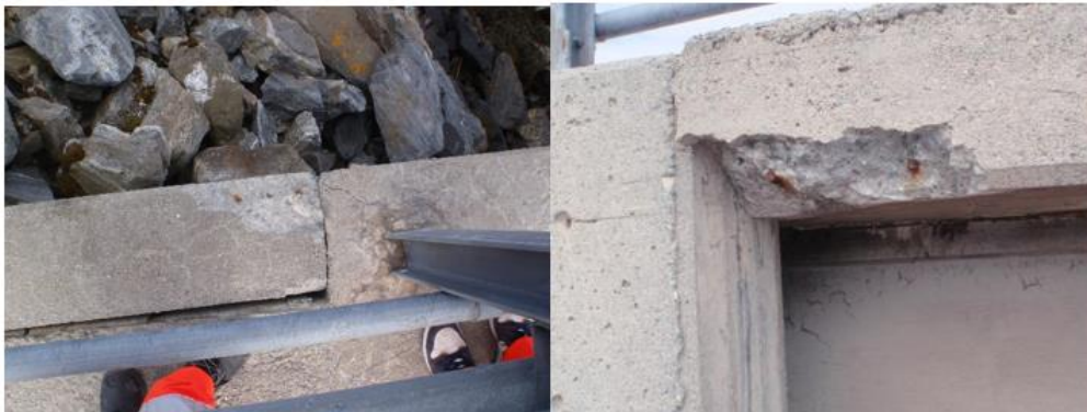
Figur 7.11: Bilde av knusing av landkar og korrosjon på Lysøybrua (Foto: BRUTUS, Statens Vegvesen)
