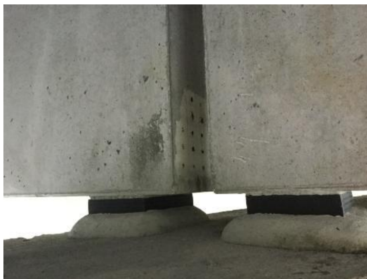
Figur 7.13: Bilde av Einang bro (Foto: BRUTUS, Statens Vegvesen)
