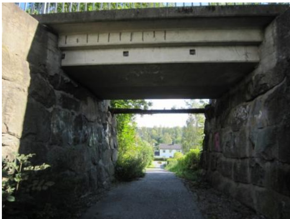
Figur 7.9: Bilde av Åsvei gangbro (Foto: BRUTUS, Statens Vegvesen)
