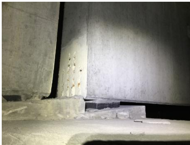
Figur 7.16: Bilde av Tveite bru (Foto: BRUTUS, Statens Vegvesen)
