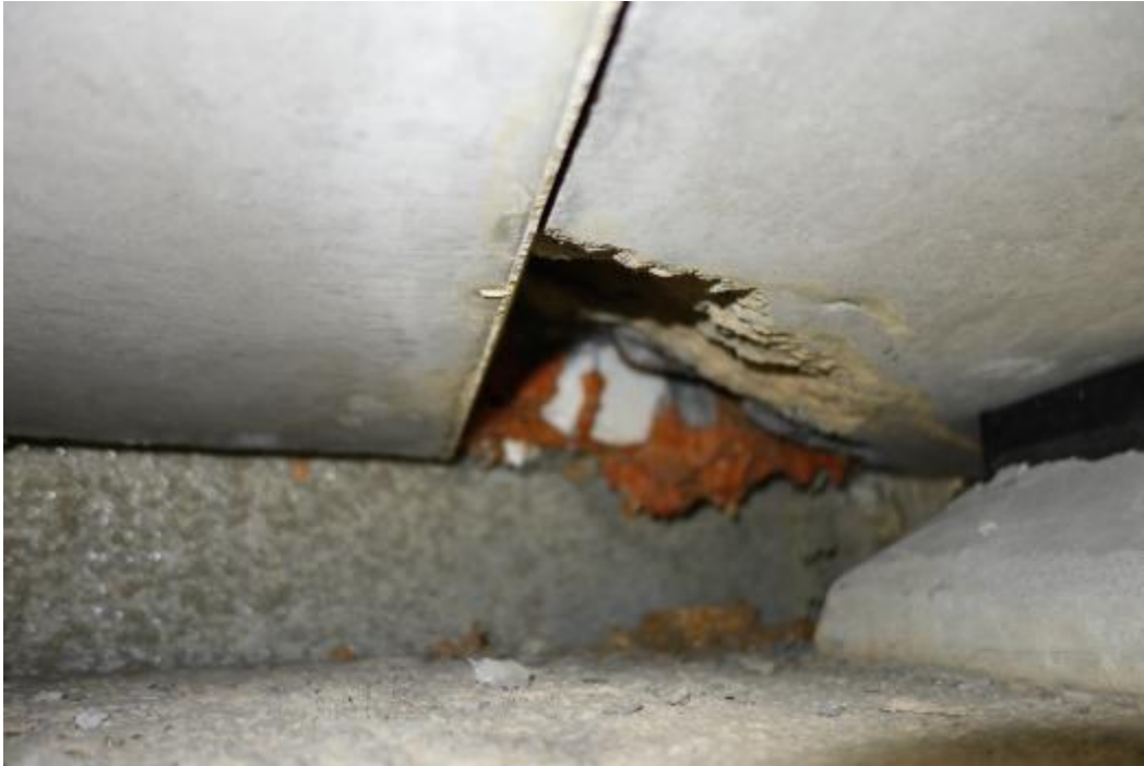
Figur 7.18: Bilde av Grøntuva bru (Foto: BRUTUS, Statens Vegvesen)
