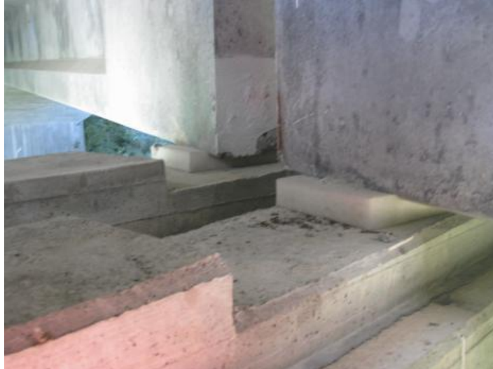
Figur 7.17: Bilde av Gjøåbrua (Foto: BRUTUS, Statens Vegvesen)
