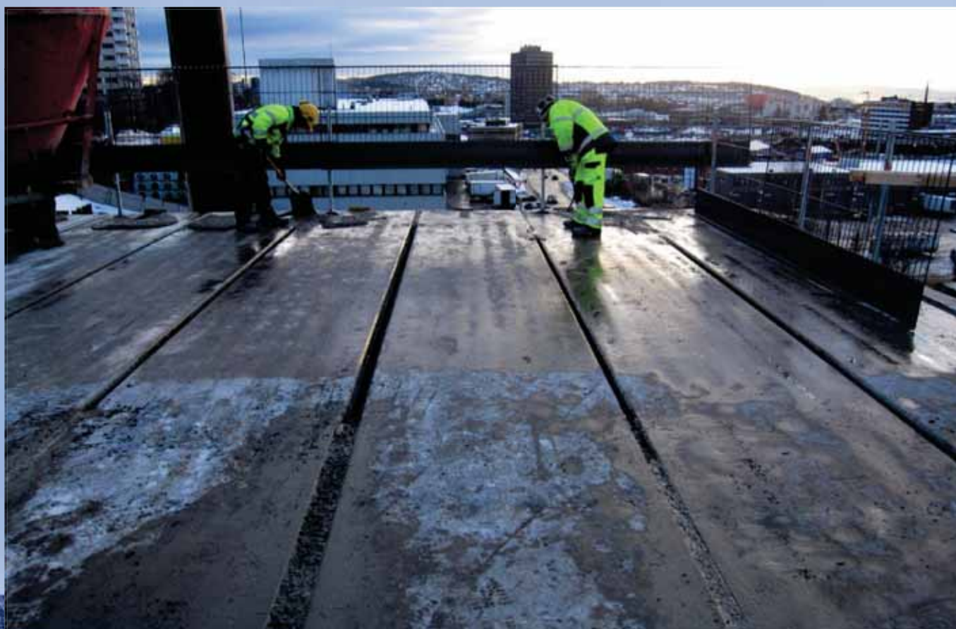
Fugging av hulldekker. Illustrasjonsfoto: AF Gruppen.
