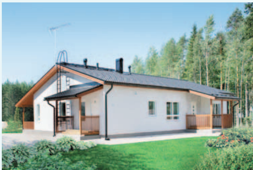
Et tett passivhus laget av betongelementer (luftlekkasje verdi målt av VTT n50= 0.09). Bilde: Suutarinen-Yhtiöt.
