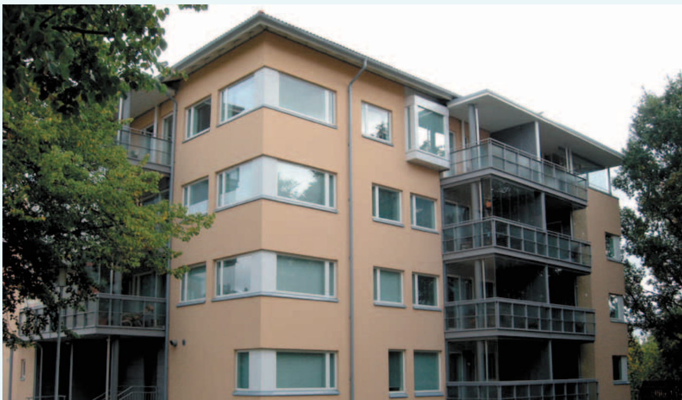
Rakennusliike Reponen Oy bygget en lavenergi boligblokk med eget konsept for ATT i Katariina Saksilainens vei i Helsinki.
