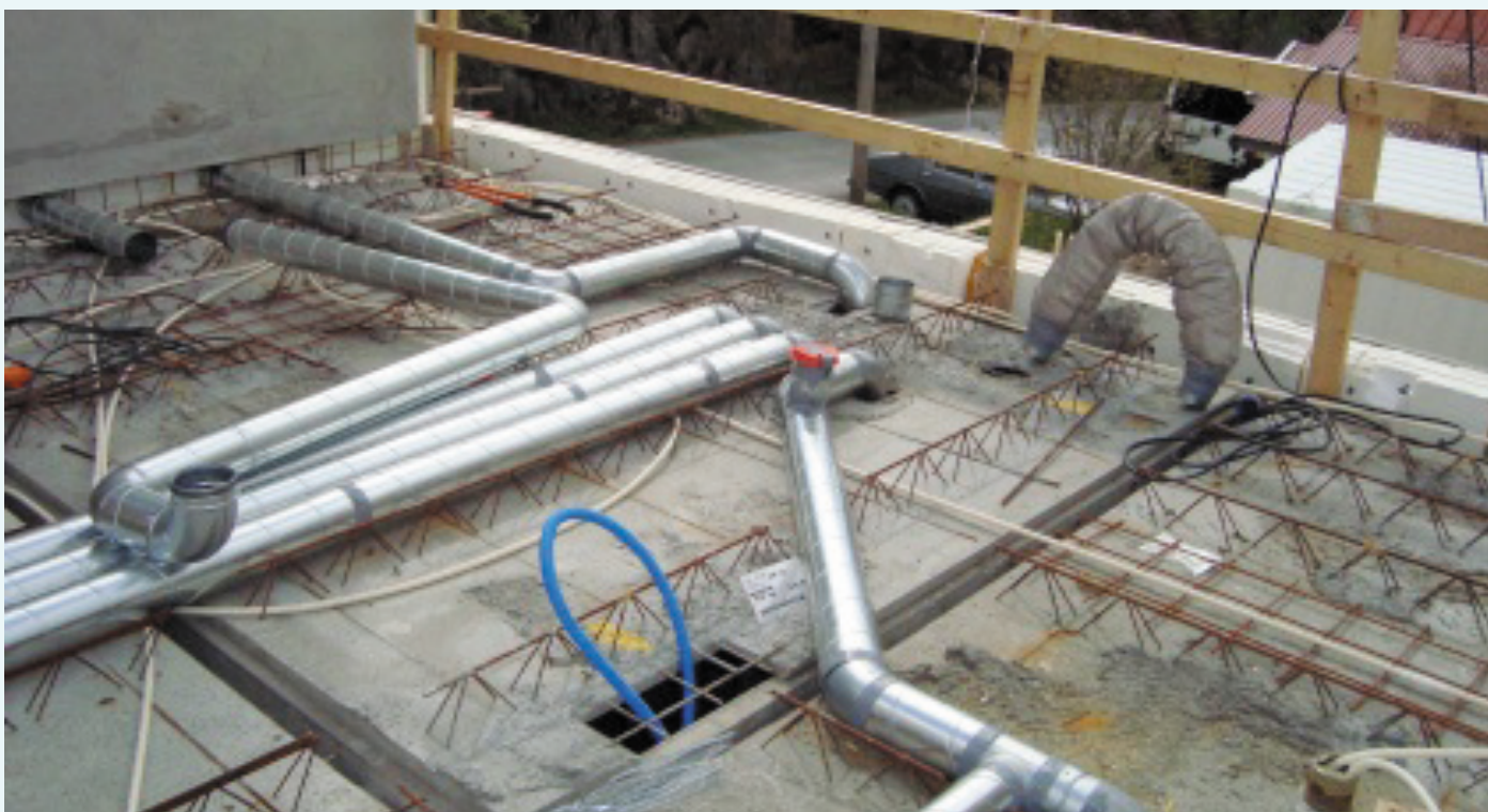
Dekket klargjort med ventilasjonskanaler før innstøping i betong.
